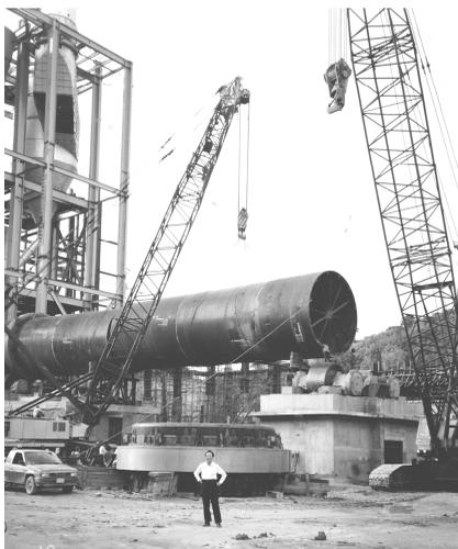
工业公司” (Thai Petroleum Industries, Inc.) 名下, 在北标府 (Saraburi) 一片荒野土地上进行土木工程、开辟石灰石矿山, 并立即聘我为第一任水泥厂厂长, 主持大局。定案后, 公司正名为“泰石油宝麟公司”(TPI Polene, Inc.) 并向德国名公司, 诸如克虏伯-波力西亚斯公司 (Krupp-Polysius Co.) 等采购机电设备。1994年8月, 第一套设备开始生产——主机旋窑之日产能力瞬即超过 7,500 公吨保证量。
